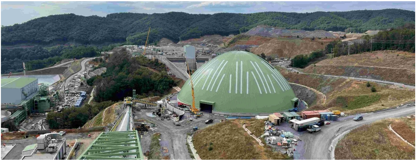
Θόλος αποθήκευσης χονδροειδούς μεταλλεύματος
